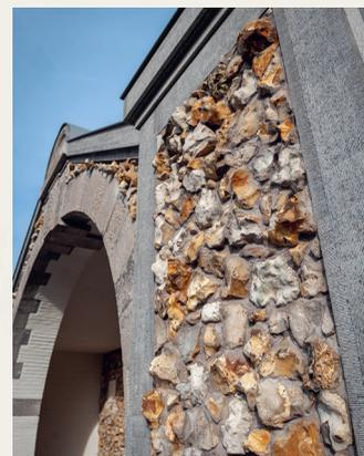
**3** La paroi rocheuse rustique (les rocailles dans le jargon), composée de pierres et de mortier, est remise à l'honneur.
